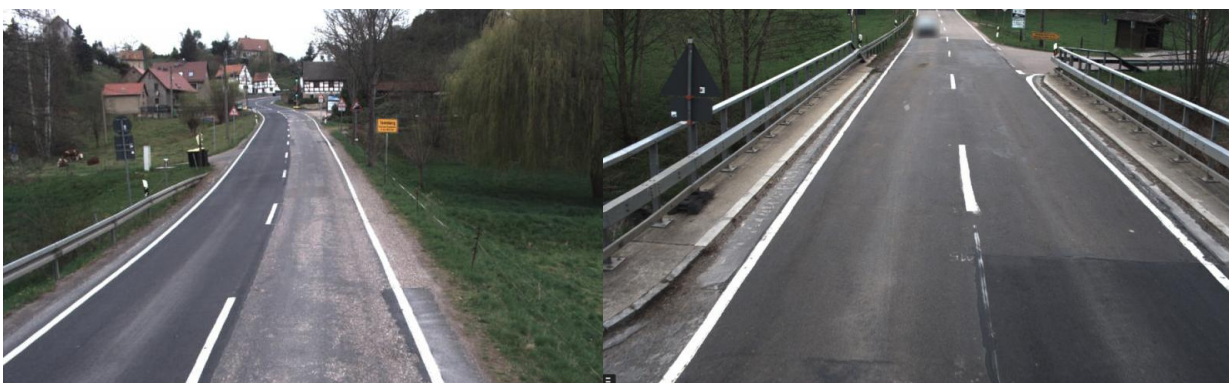
Abbildung 15: S 36 Streckenbilder nach Durchführung von Maßnahmen von Streckenbefahrung 2025
