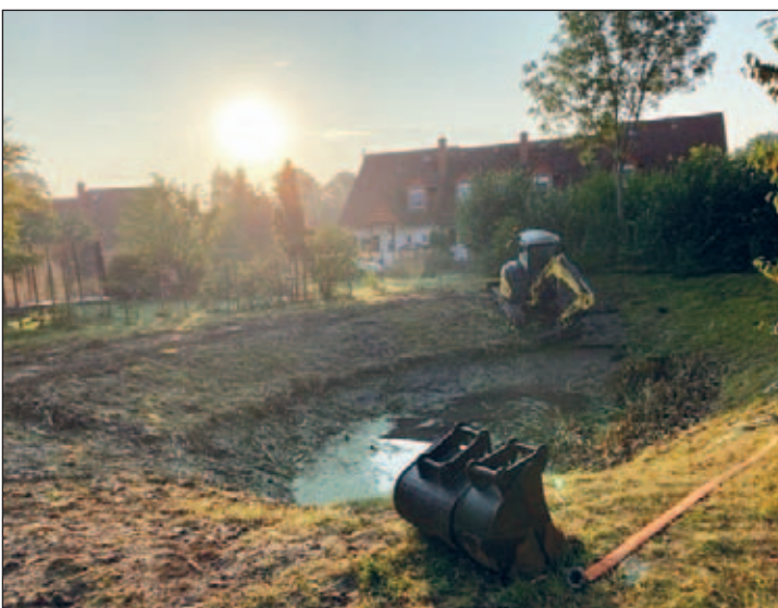
Regenklärbecken in Grumbach während der Renaturierung
