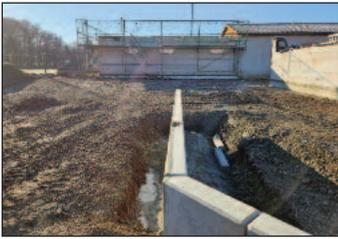
wurden die Grundleitungen zur Regenentwässerung des nördlichen Anbaus verlegt und die Winkelstützwand, als Abgrenzung zur Zuwegung des Pumptracks, wurde gesetzt. Nach der Fertigstellung des Rohbaus beginnen dann die Zimmerarbeiten zur Errichtung des Dachstuhls. Zudem laufen die Vorbereitungen zur Ausschreibung von Los 15 – Heizung, Lüftung und Sanitär.
