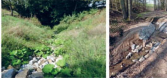
Abbildung 7 und 8: Profilierung des an die Teiche anschließenden Gewässerverlaufs, © TG Blankenstein
