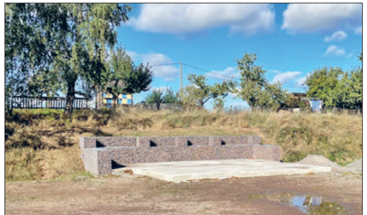
Der Baufortschritt auf dem Platz neben dem Lokschruppen Mohorn
