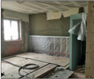
Die Stahlträger im 1. OG sind eingebaut und bereits verkleidet. Derzeit erfolgen in der gesamten Etage die Trockenbauarbeiten. Die neuen Wände sind teilweise gestellt und die Decken vorbereitet. Anschließend erfolgt der Wandputz und der Fußbodenaufbau. Parallel dazu erfolgen weiter die Verlegearbeiten der Elektro- und Sanitärinstallation. In den Gruppenräumen im Erdgeschoss des Altbaus wurden neue Fluchtwegtüren eingebaut und im Außenbereich die entsprechenden Podeste mit Stufen hergestellt.
