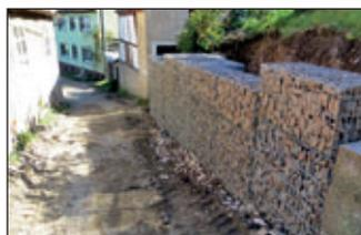
Ein erster Teil der Steinsgasse wurde asphaltiert. Hier handelt es sich um den besonders engen und steilen Abschnitt. Die ursprünglich geplante Pflasterung war bautechnisch nicht umsetzbar, da durch die starken Vibrationen beim Abrütteln des Pflasters Schäden an den unmittelbar an der Straße stehenden Gebäuden entstanden wären. Dazu wurden im Vorfeld Schwingungsmessungen durchgeführt.
