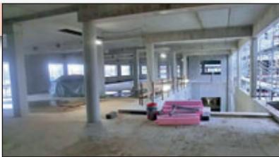
Die äußere Hülle im Gebäudeteil „Sekundarstufe 2“ ist dicht. Damit konnten die Ausbaugewerke, wie Trockenbau, Estrichbauer und die Haustechnikgewerke, in diesem Gebäudeteil beginnen. Aktuell erfolgt eine Beheizung mit einer Winterbaubeheizung und die Heizungstrassen innerhalb des Gymnasiums werden verlegt.
