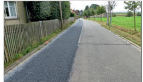
Eindringen von Wasser verhindert. Mit diesen Verfahren können die Straßen über weitere Jahre in einem guten Zustand gehalten werden. In Grund zwischen Buswendeplatz und Parkplatz am Bad konnte vorgenanntes Verfahren nicht mehr sinnvoll eingesetzt werden, da die Schäden in der Deckschicht zu groß waren. Hier halfen nur das Abfräsen und der Einbau einer neuen Asphaltdeckschicht. An weiteren Straßen erfolgte der Verguss von Rissen im Asphalt, leider konnten nicht alle beseitigt werden.
