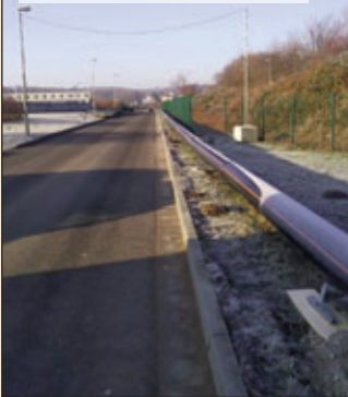
Der Rohrstrang wartet auf den Einzug
