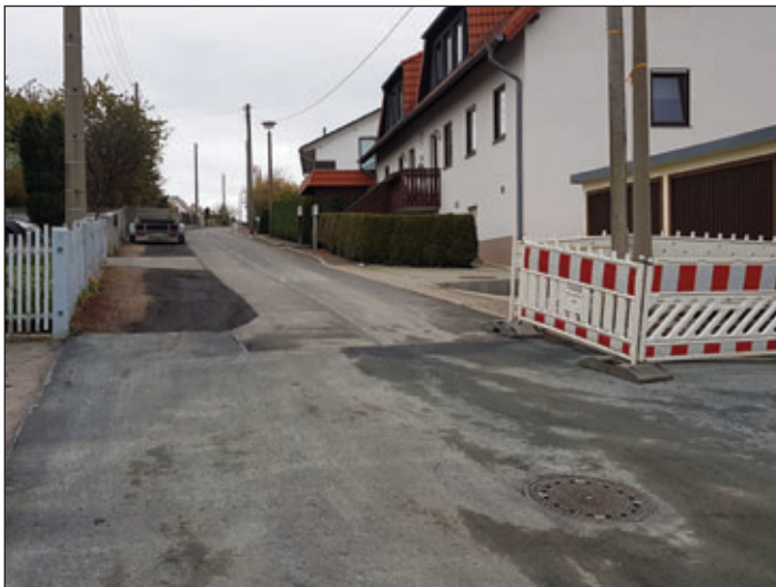
Blick im Bereich Wendehammer
