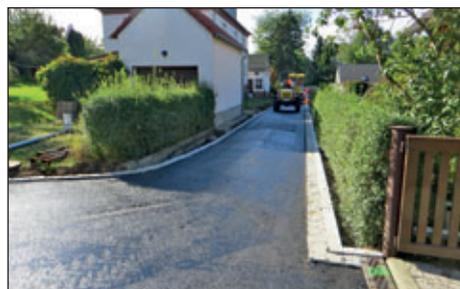
nicht mehr zeitgemäß. Vor dem Straßenbau wurde ein neuer Regenwasserkanal verlegt, welcher nun eine geordnete Oberflächenwasserableitung garantiert. Im Zuge des Straßenbaus wurden drei neue LED-Leuchten errichtet.
