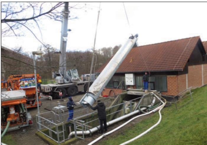
Erneuerung der zwei Rohrschneckenpumpen im Zulaufpumpwerk
