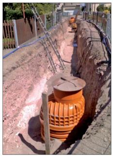
Die insgesamt ca. 840 m lange, neue Freispiegelkanalisation in der Kesselsdorfer Straße, Saalhausener Straße, Kleinopitzer Straße, Kurze Straße und Müllers Weg wurde komplett verlegt. Dies beinhaltet auch die Errichtung Hausanschlüsse bis zum Prüfschacht. Ein Großteil der Grundstücksbesitzer hat sich auch schon an den Prüfschacht schlossen.
