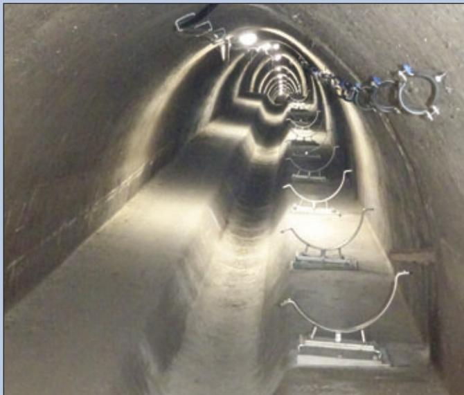
▲ Vorbereitete Gleitlager für Druckleitung
