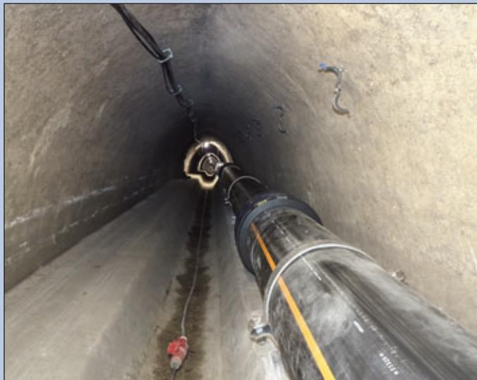
▲ Montierte Druckleitung im Regenauslasskanal
