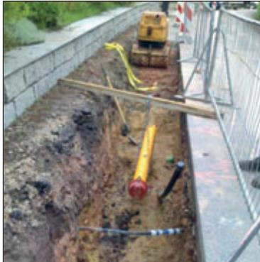
Das Bauvorhaben begann mit der Verlegung der Abwassersammeldruckleitung aus PE-HD d63 in der Nordstraße. Wie bei der Abwassersammeldruckleitung wird seit Mitte Mai auch bei dem Freispiegelkanal DN 200 PVC-U gemeinsam eine Gasversorgungsleitung der Freitaler Strom + Gas GmbH mitverlegt (Bild 1). Durch die gemeinsame Verlegung können so Kosten eingespart werden.
