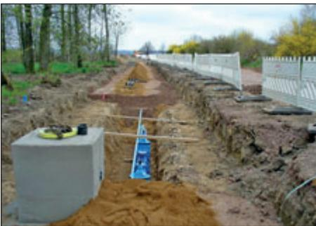
Im Zuge dessen wurde 2015 die Trinkwasserleitung DN 200 von der Dresdner Straße bis zur Fa. Eberspächer neu verlegt. Mit der Maßnahme wurde am 9. September 2014 durch die Fa. Wolff & Müller begonnen und im November 2015 konnte die Fertigstellung dieses Bauabschnittes angezeigt werden.
