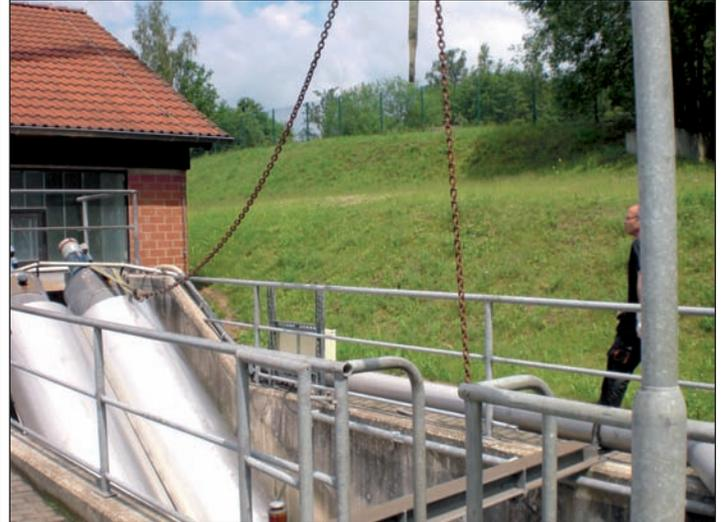
Auf der KA Klipphausen gibt es 2 Zuläufe. Zum einen eine Druckleitung aus der Großgemeinde Klipphausen und zum anderen einen Kanal aus der Stadt Wilsdruff. Dieser Kanal verläuft ca. 4,50 m unter dem Kläranlagen-Niveau. Damit das Abwasser in die Kläranlage gehoben werden kann, ist der Einsatz von Zulaufschnecken notwendig. Über
