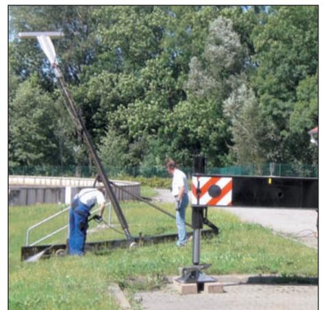
Um in den Nachklärbecken eine Klarwasserzone zu bilden, setzt sich der Klärschlamm an der Beckensohle ab. Dieser wird mittels Räumschilder zum Rücklaufpumpwerk gefördert. Die Nachklärbecken verfügen an der fahrbaren Brücke über jeweils 3 Räumschilder.
