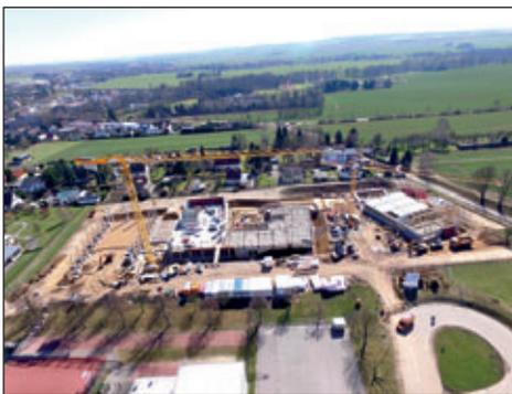
Während im Gymnasium die Decken über dem Untergeschoss und über dem Erdgeschoss sowie Außenwände betoniert worden sind, konnten in der Sporthalle die Fertigteilstützen gestellt werden.
