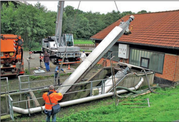
Ausbau der Zulaufschnecken auf der KA Klipphausen
