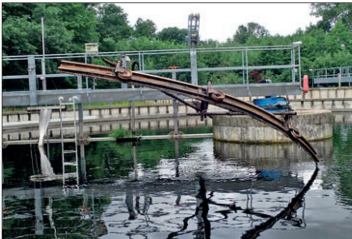
Des Weiteren wurden die Sandförderpumpe im Sandfang erneuert und die Beckenkronen der Belebungsbecken durch die Firma Drebbau saniert. An den Nachklärbecken der Anlage erfolgte die turnusmäßig notwendige Instandsetzung der Räumschilder.
