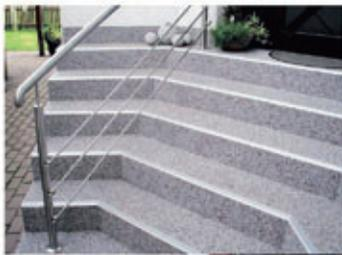
mehrere Arbeitsschritte notwendig. Nach der Grundierung und Abdichtung folgt die hellgraue oder dunkelgraue Kunststoffbeschichtung, die mit einer Rolle aufgetragen wird. Durch das anschließende Aufstreuen farbiger Chips auf die noch flüssige Masse ergeben sich durch individuelle Farb- und Mengenkombinationen viele Gestaltungsmöglichkeiten. Zum Abschluss benötigt die Oberfläche noch eine transparente Versiegelung.
