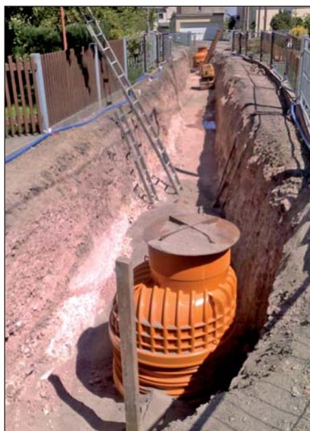
Die insgesamt ca. 840 m lange, neue Freispiegelkanalisation in der Kesselsdorfer Straße, Saalhausener Straße, Kleinopitzer Straße, Kurze Straße und Müllers Weg wurde komplett verlegt. Dies beinhaltet auch die Errichtung der Hausanschlüsse bis zum Prüfschacht. Ein Großteil der Grundstücksbesitzer hat sich auch schon an den Prüfschacht angeschlossen.
